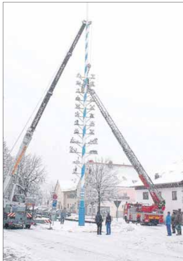
Mit Hilfe des großen Autokrans und der Feuerwehrleiter wurde der Dießener Maibaum umgelegt.
